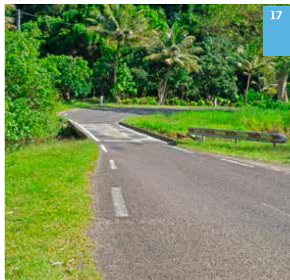
Pont de Petit Kokingone à Touho
