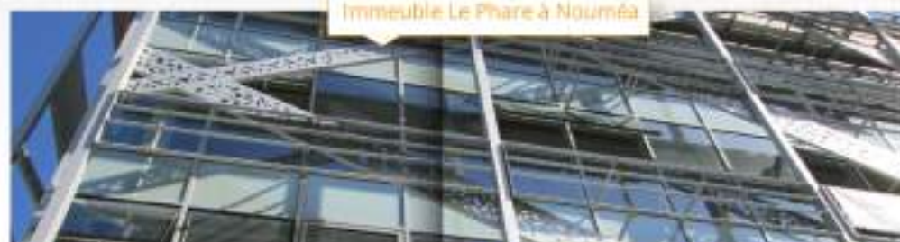
Immeuble Le Phare à Nouméa
