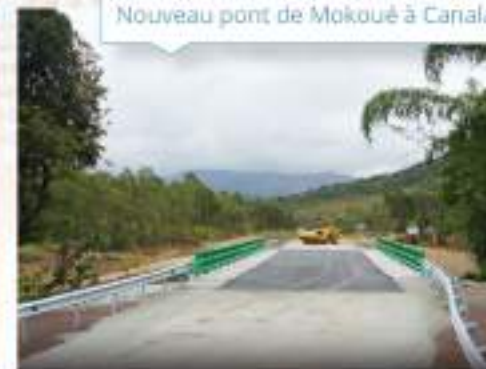
Nouveau pont de Mokoué à Canala
