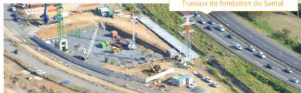
Travaux de fondation du Santal
