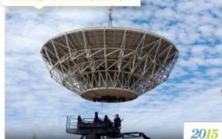
Démontage de l'antenne parabolique
