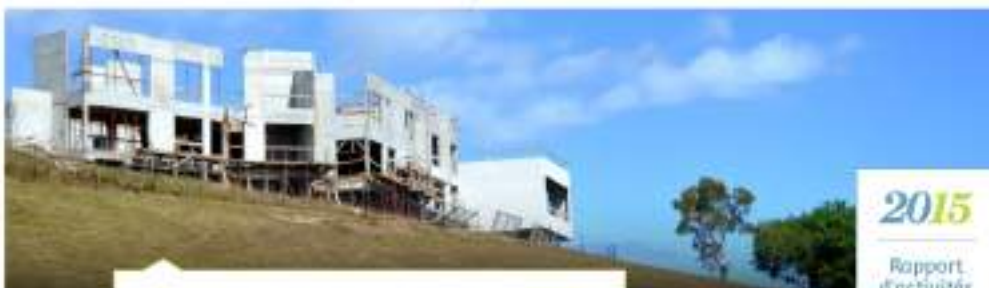
Avancement du chantier (octobre 2015)
